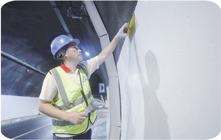
施工人员对隧道衬砌渗漏水以及裂缝等存在的结构性问题进行系统性修复
