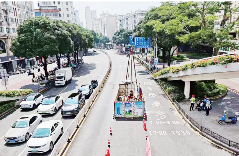
施工团队在胜利路初勘预设点位进行勘探
